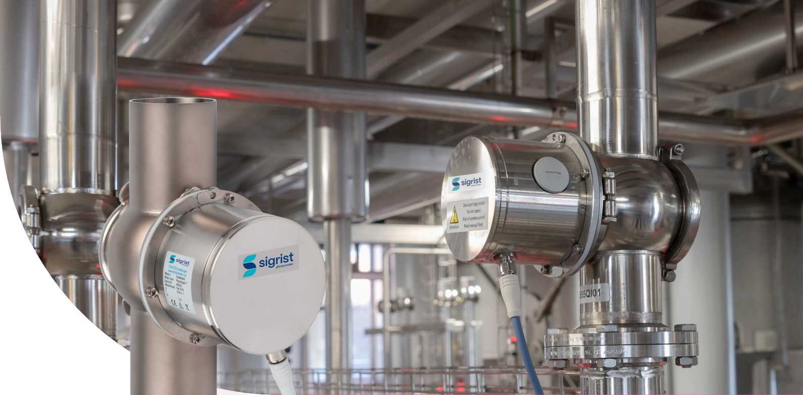
Das PhaseGuard in Variventgehäuse
