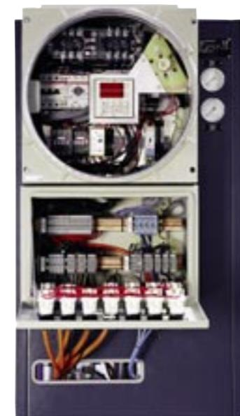
der inneren Verlustleistung die Oberflächentemperaturen entsprechend der jeweiligen Temperaturklasse den anzuwendenden Normen genügen. Durch eine Stückprüfung wird die Einhaltung der Temperaturgrenzen (die heißeste Stelle aussen am druckfesten Gehäuse bzw. im Innern der Anschluss- und Sammelschienenkästen) entsprechend der jeweiligen Temperaturklasse vom Hersteller gewährleistet.
