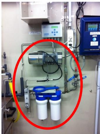
Bild 5: ColorPlus Bypass in Rohwasser mit Probenfiltration
